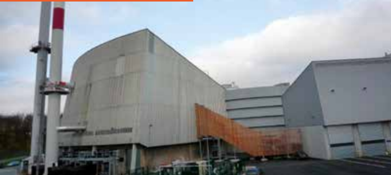
CHAUFFERIE ADP ROISSY 38 000 T/AN
