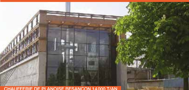
CHAUFFERIE DE PLANOISE BESANÇON 14 000 T/AN
