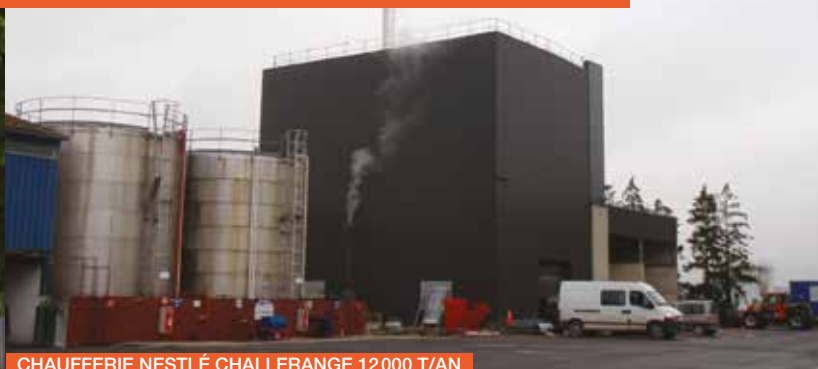
CHAUFFERIE NESTLÉ CHALLERANGE 12 000 T/AN
