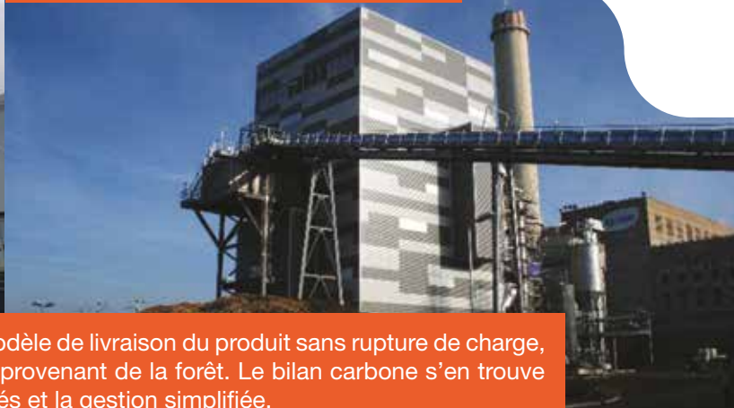
CENTRALE DE COGÉNÉRATION DE METZ 35 000 T/AN
